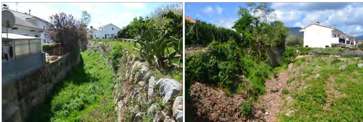
Imatge 17. La riera de la Vallmanya, des de la prolongació del carrer de la Font de Sant Antoni (imatge de l'esquerra) i des del pont de la BV-5301 (imatge de la dreta). En les dos imatges es pot observar la presència d'elements fixadors canalitzadors de la riera, com murs de contenció i rocalles.
