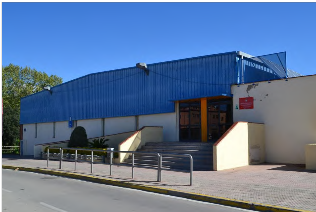
Imatge 18. El pavelló esportiu, amb les plaques de captació d'energia solar per aigua calenta sanitària.
