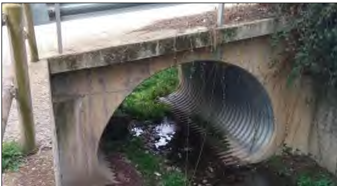
Imatge 13. Obra de pas de la riera de la Vallmanya en la prolongació de la Font de Sant Antoni / Barcelona
